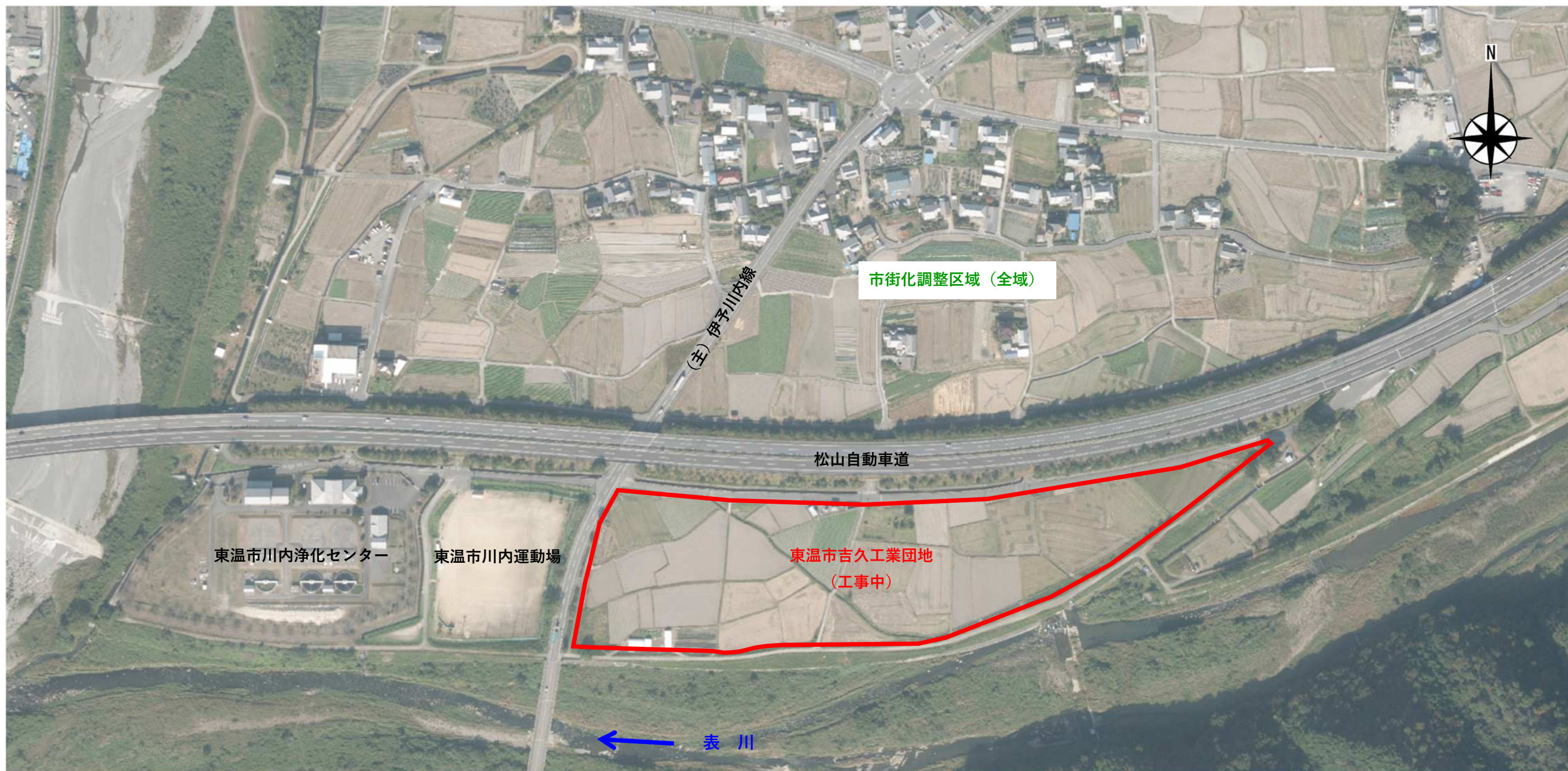
周辺の土地利用状況写真（工事着手前）
