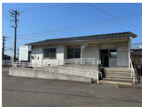
図 29 スロープと点字ブロックが整備されている牛淵駅
