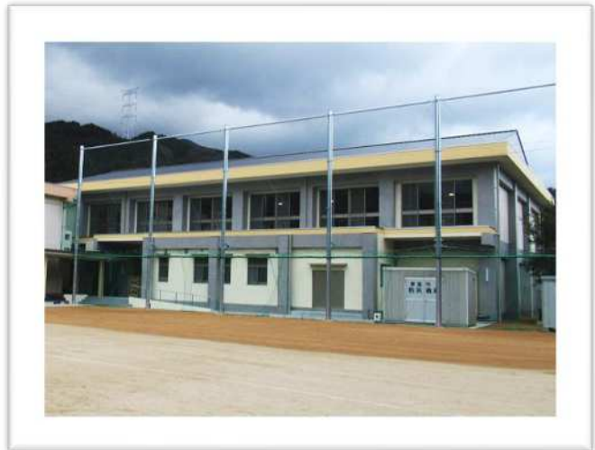
改築した東谷小学校屋内運動場▲
