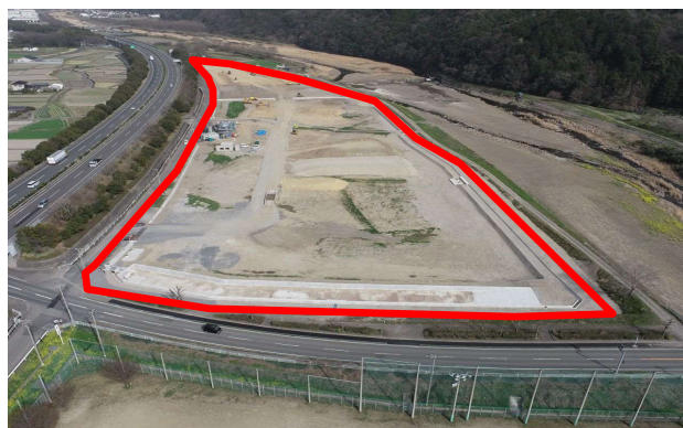
吉久工業団地 工事中写真
