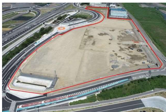
田窪第2工業団地 工事中写真
