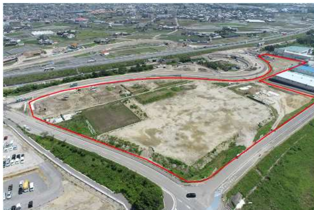
田窪第2工業団地 工事中写真
