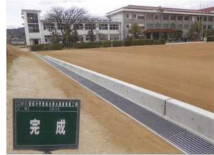
重信中学校雨水排水設備工事
