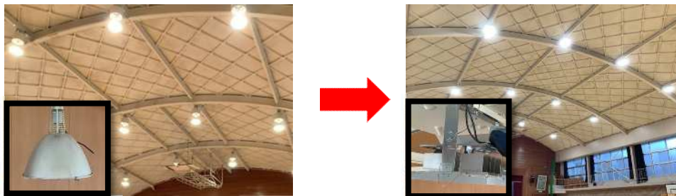
北吉井小学校屋内運動場照明設備改修工事
