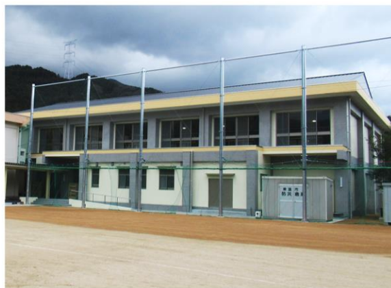
改築した東谷小学校屋内運動場▲
